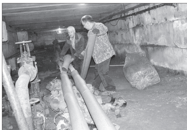
Ремонтники «Жилсервиса» ведут работы по теплоизоляции системы отопления.
