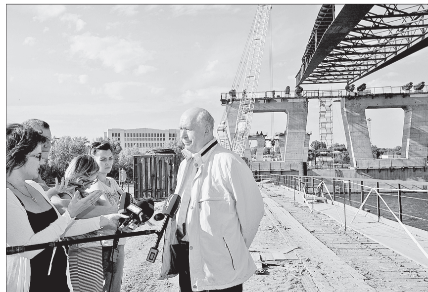
Под вниманием губернатора находится строительство Фрунзенского моста. Проект реализуется при поддержке федерального центра. В очередной визит на площадку возводимого мостового перехода Николай Иванович Меркушкин ознакомился, как идут работы. Фрунзенский мост даст импульс развитию районов областной столицы по обеим сторонам реки Самары. В центральной части города мост будет соединяться с улицами Куйбышева, Фрунзе, Чапаевской, Молодогвардейской, а также с Хлебной площадью.
