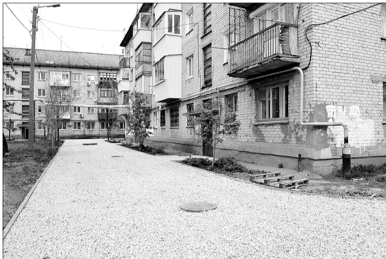
Ремонтные работы во дворе дома № 98 по улице 50 лет Октября.
