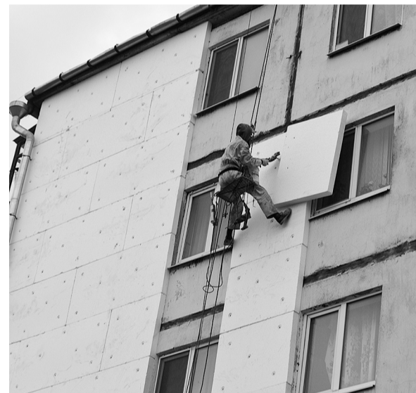
Сначала - плиты теплоизоляции, затем - фасадная штукатурка, и в квартирах будет еще теплее.
