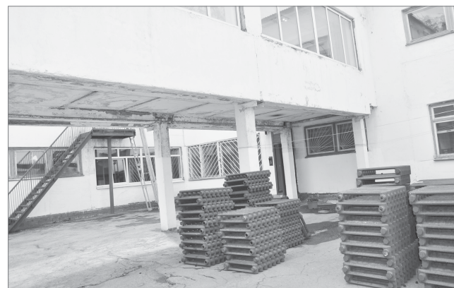
В детском саду «Сказка» проводятся работы по ремонту всех инженерных коммуникаций.
