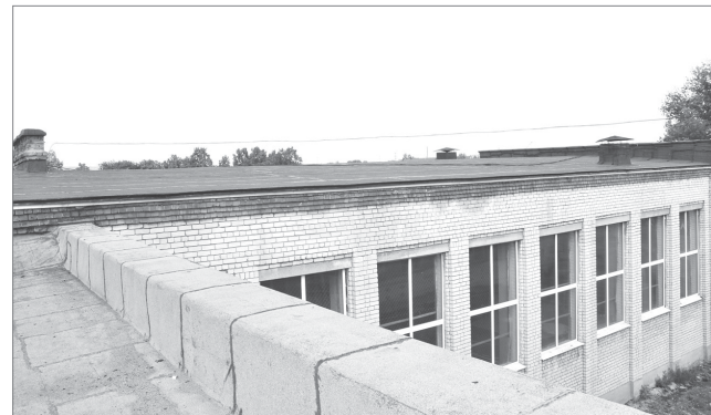
Первая часть ремонтных работ по кровле в школе № 1 проведена.
